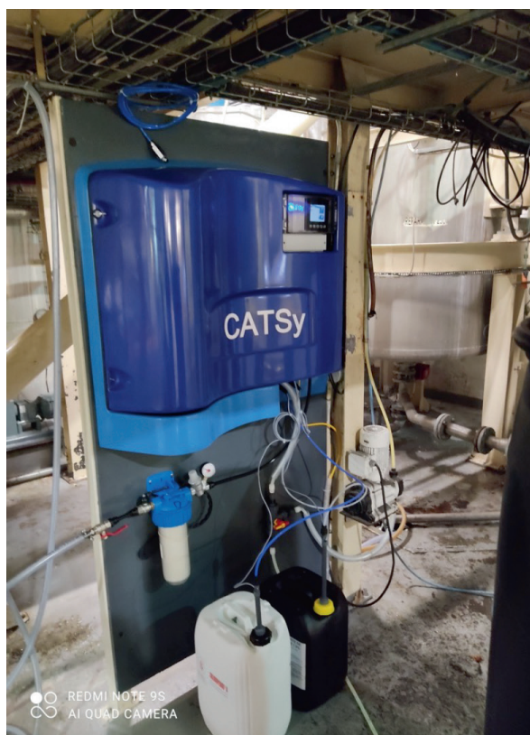
Désinfection d'eau en sortie de station à l'aide d'un générateur de dioxyde de chlore (75 000 m 3 /an). ©Minerve Technology
