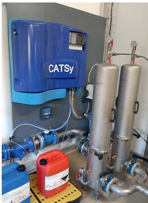
Désinfection d'eau en sortie de station à l'aide d'un générateur de dioxyde de chlore (75 000 m 3 /an). ©Minerve Technology
