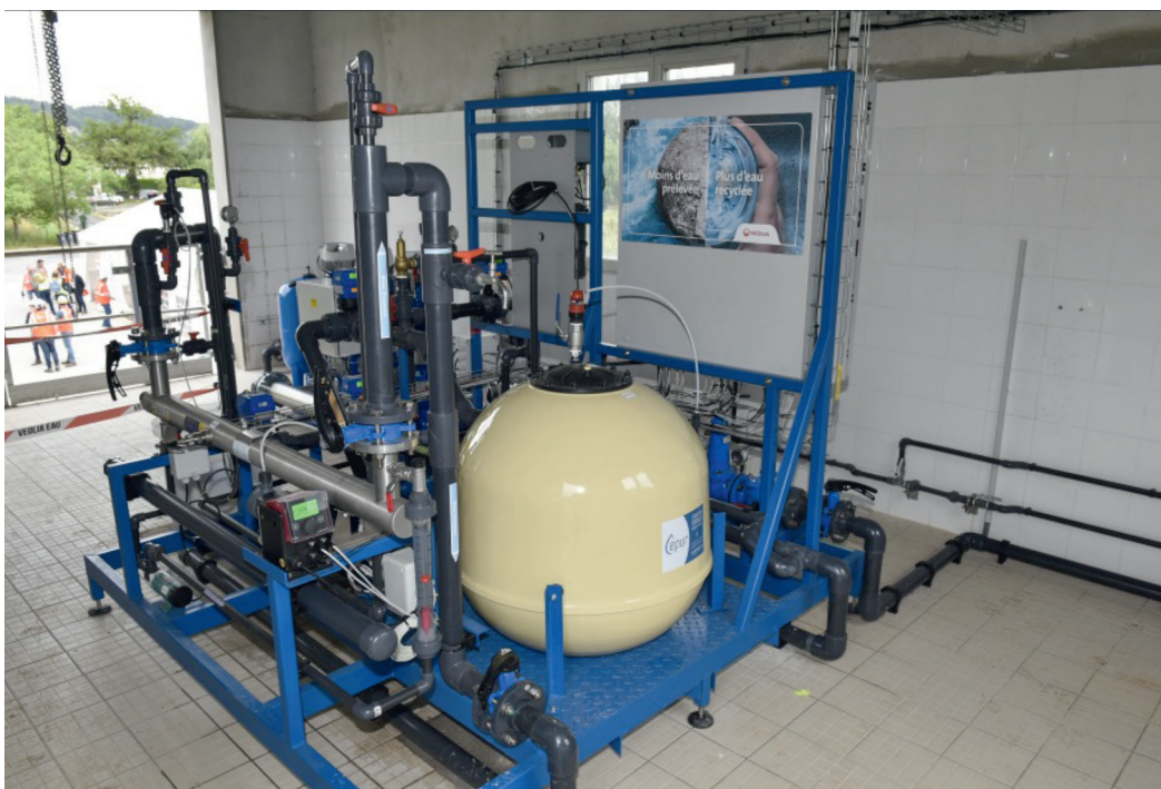
Exemple de skid de réutilisation des eaux usées installé dans une usine d'épuration (production 5 m 3 /h). ©UVGERMI
