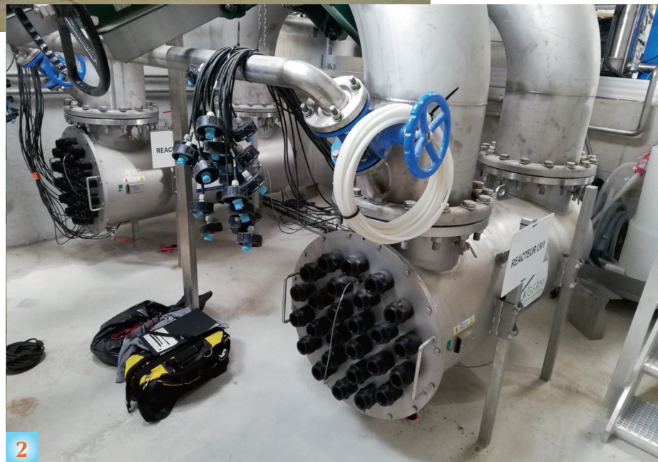
1 Réacteur UV pour REUT Irrigation d'un Golf, débit 100 m 3 /h ©Bio-UV Group
