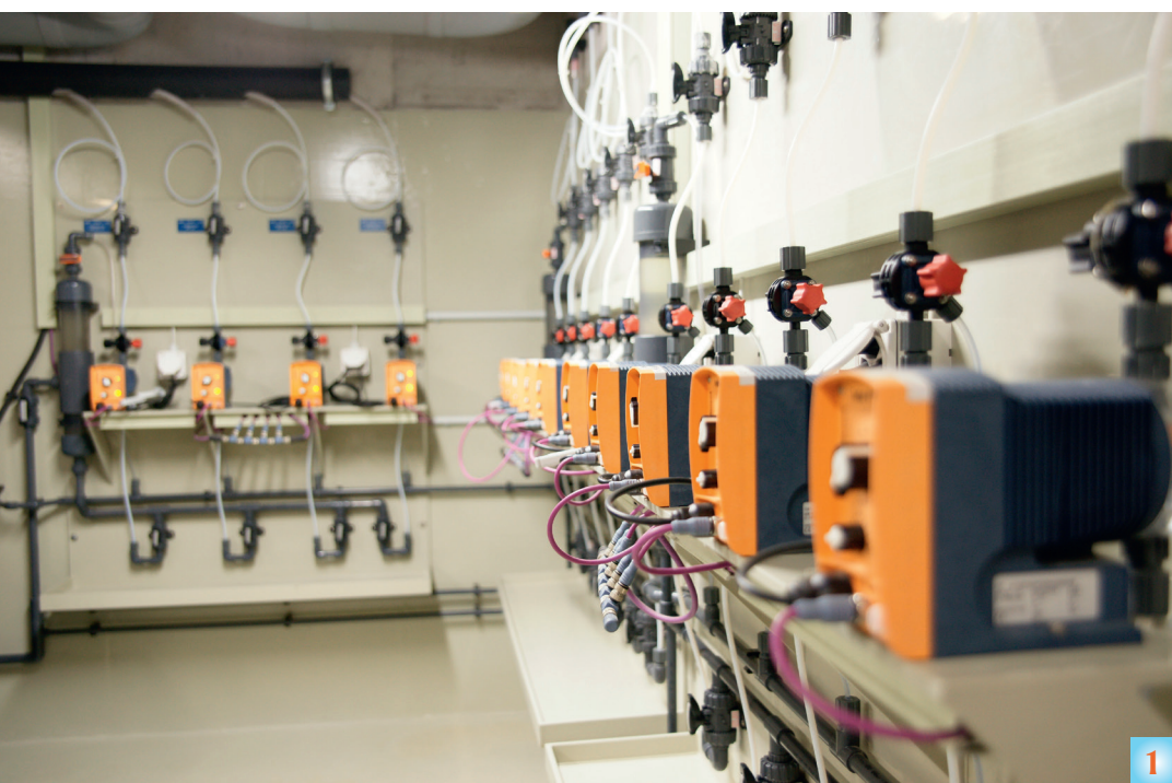
1 Pompes doseuses pour chlore ou correcteur de pH. ©ProMinent
