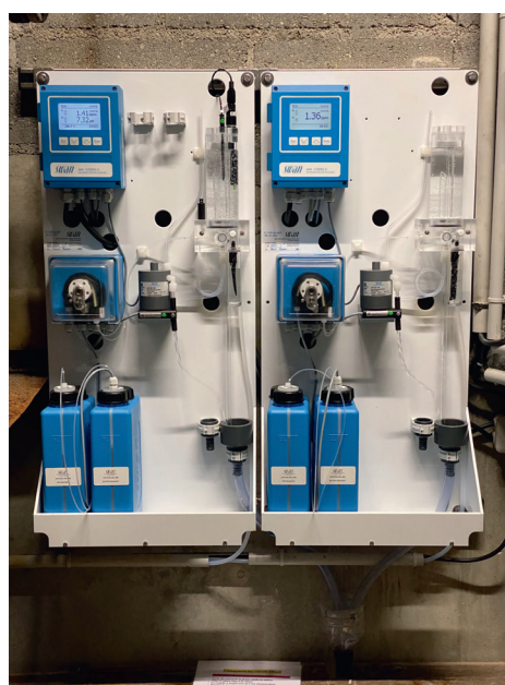
Exemple d'analyse et régulation en continu des oxydants dans une piscine municipale. @SWAN
