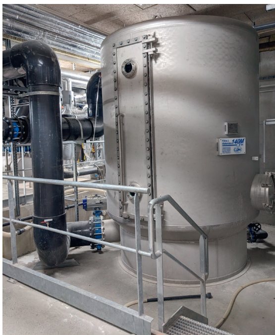
Exemple d'un filtre d'un centre aquatique. ©Cifec
