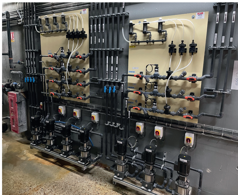
Local de chloration au chlore gazeux pour un ensemble de 7 bassins. ©CIR
