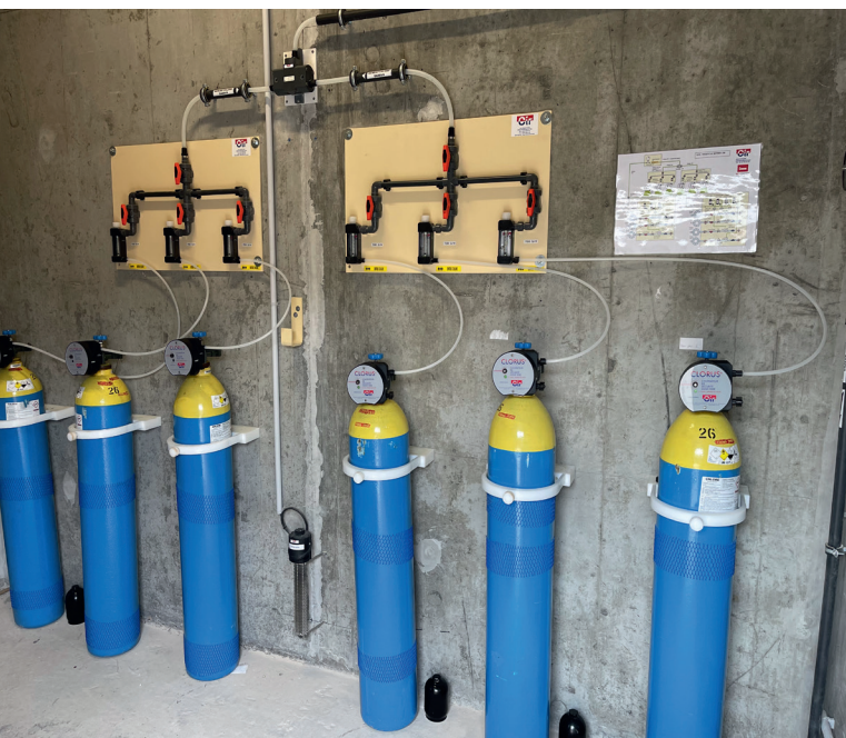
Local de chloration au chlore gazeux pour un ensemble de 7 bassins. ©CIR
