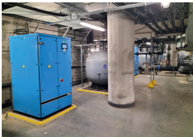
Exemple de générateur d’ozone de 260 g d’ozone par heure à partir d’air. ©BIO-UVgroup
